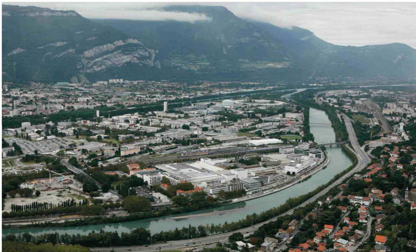
Minatéc, au nord-ouest de Grenoble, sur la presqu'île entre Drac et Isère. Un campus dédié aux micro et nanotechnologies ouvert en 2006.
